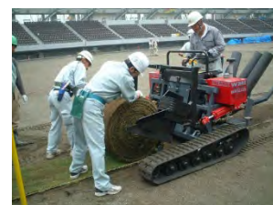
スタジアムでの施工の様子
