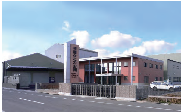
甲陽ケミカル(株)境港工場
